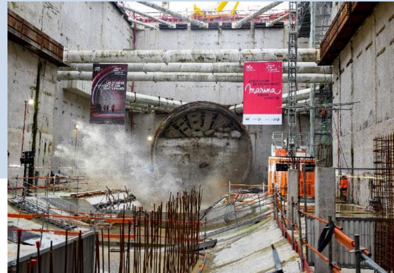
Percement du tunnelier Marina à Créteil l'Echat
