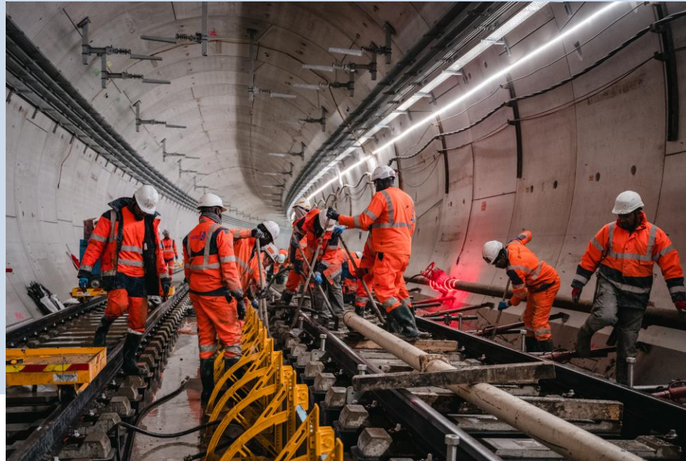
Pose des rails bas-carbone au Bourget Aéroport - janvier 2023
