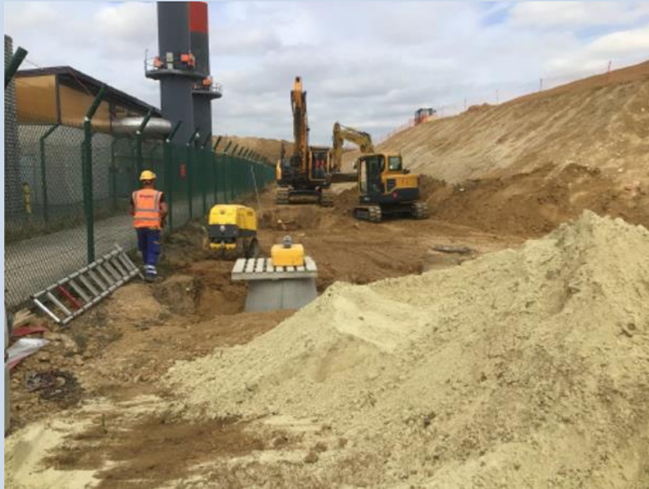
Travaux préparatoires en cours sur la zone aéroportuaire CDG
