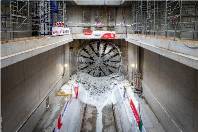
Percement du tunnelier Mireille à l'Ouvrage Bellevue à Livry-Gargan
