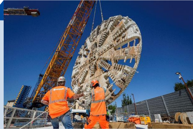
Levée de la roue de coupe du tunnelier Florence au Bourget
