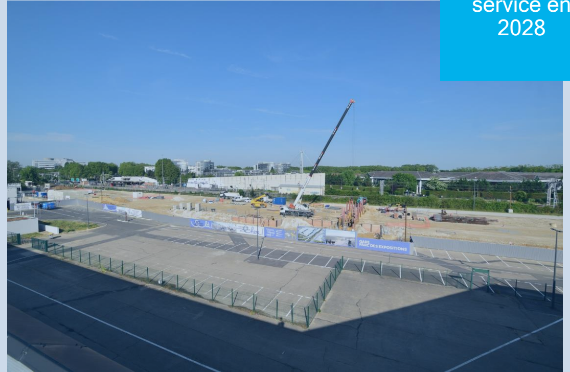
Lancement des travaux de la gare Parc des Expositions et de la section aérienne - fin 2022
