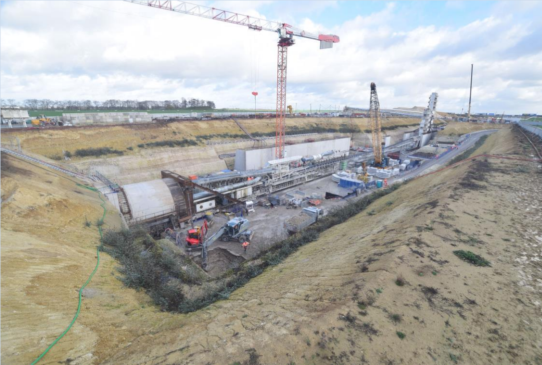
Départ du tunnelier Florence à Triangle de Gonesse - janvier 2023
