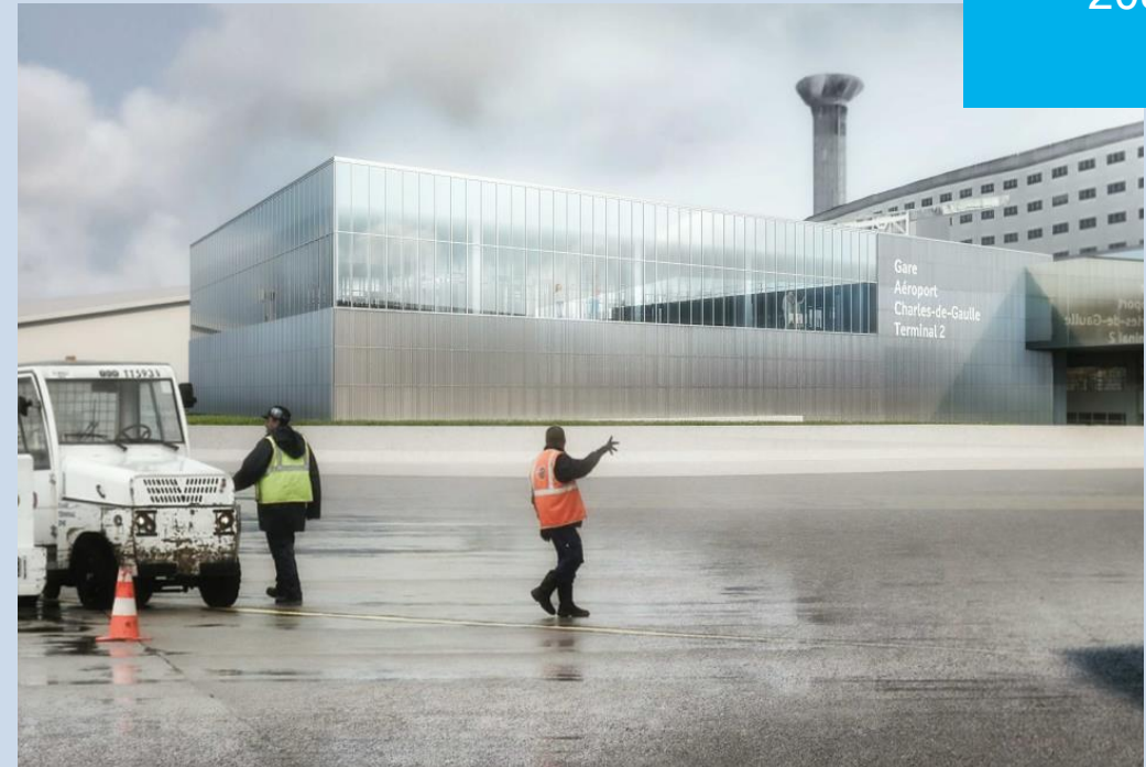
Notification du dernier marché génie civil de la ligne 17 - fin 2023
