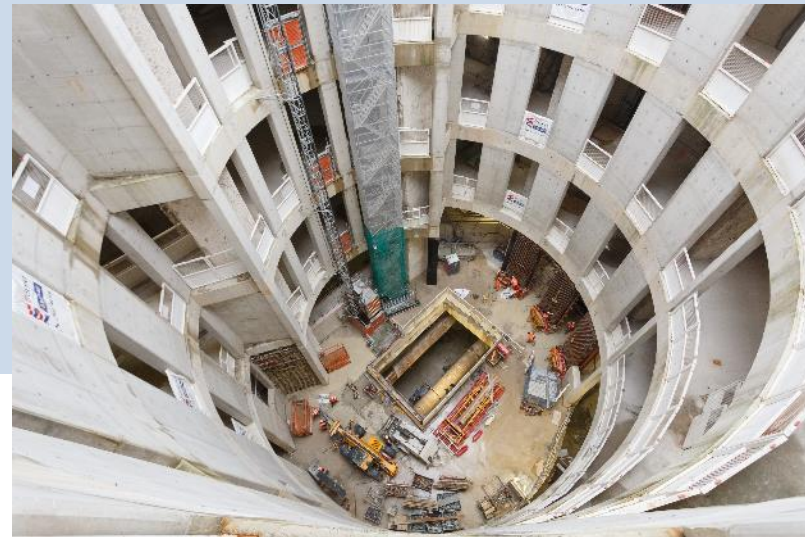
Gare Saint-Maur - Créteil
