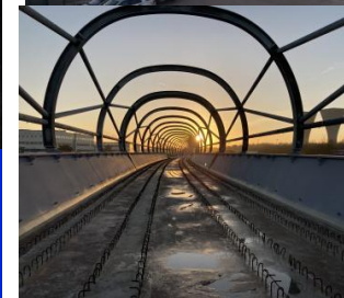
Le viaduc de la ligne 17 est entièrement réalisé, depuis la gare Triangle de Gonesse jusqu'à la gare Parc des Expositions, et se prolonge sur 800m au-delà. Les travaux de pose des voies ferrées ont démarré sur ce tronçon aérien.
