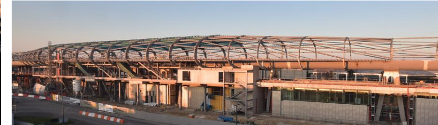
Le viaduc de la ligne 17 est entièrement réalisé, depuis la gare Triangle de Gonesse jusqu'à la gare Parc des Expositions, et se prolonge sur 800m au-delà. Les travaux de pose des voies ferrées ont démarré sur ce tronçon aérien.
